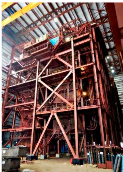
а) общий вид каркаса парового котла a) general view of the steam boiler frame
